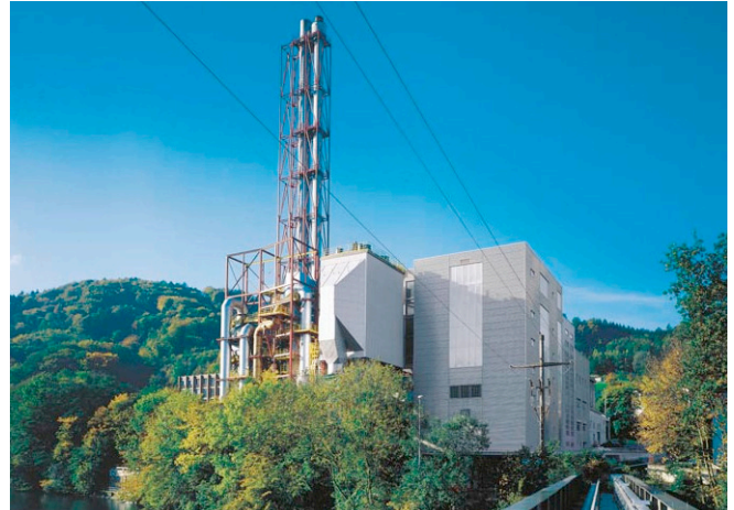
Die KVA Turgi ist ein nennenswerter Energielieferant im Aargau. Geliefert wird Fernwärme für 6500 Wohneinheiten der Region.
